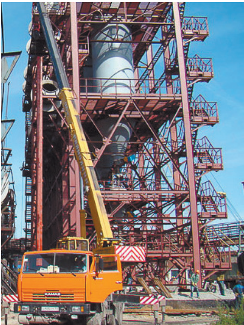
Реконструкция ВНК АО «КМЗ».
