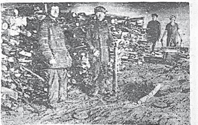
1933 год. Завод № 1. Подвозка топлива на «гофманской» печи — горне. Фото из архива газеты.
